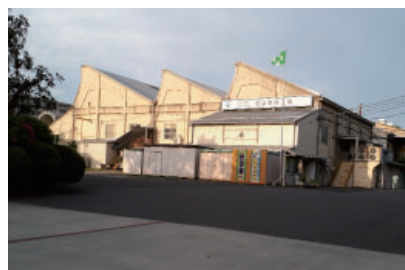
㉘富士チタンの中には火薬廠を象徴する大きな三本の煙突があった。のこぎり屋根の工場が往時をしのばせる。
