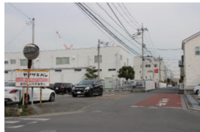
⑨火薬廠北端の道。山崎製パンからが火薬廠の北東端にあたる。
