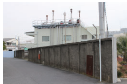
㉖高栄産業の外壁。火薬廠の塀が残る。
