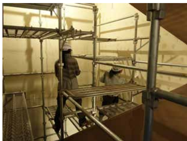
展示室・収蔵庫の空調運転の安全を確保すべく、地下にある制御室への階段から工事を始めました(11月10日:壁面の修復作業)
