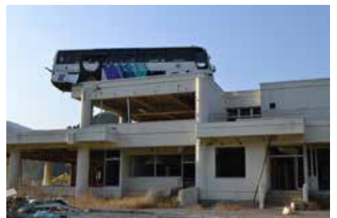
津波により建物2階に乗り上げたバス (宮城県石巻市雄勝町)
