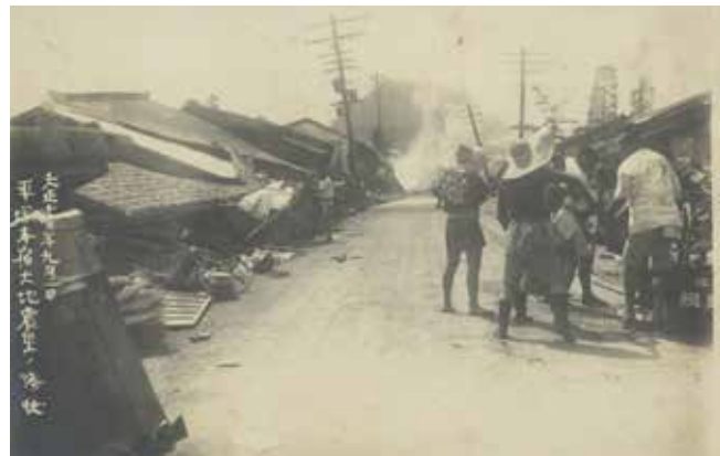
▲大正関東地震により家屋が倒壊した平塚本宿周辺の様子。
