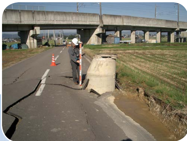
上 液状化で浮き上がったマンホール (新潟県中越地震・大野氏撮影) 左 かつての礫が地震で隆起した湘南平
