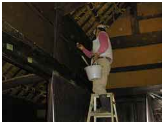
補強した民家の内壁を塗っている
