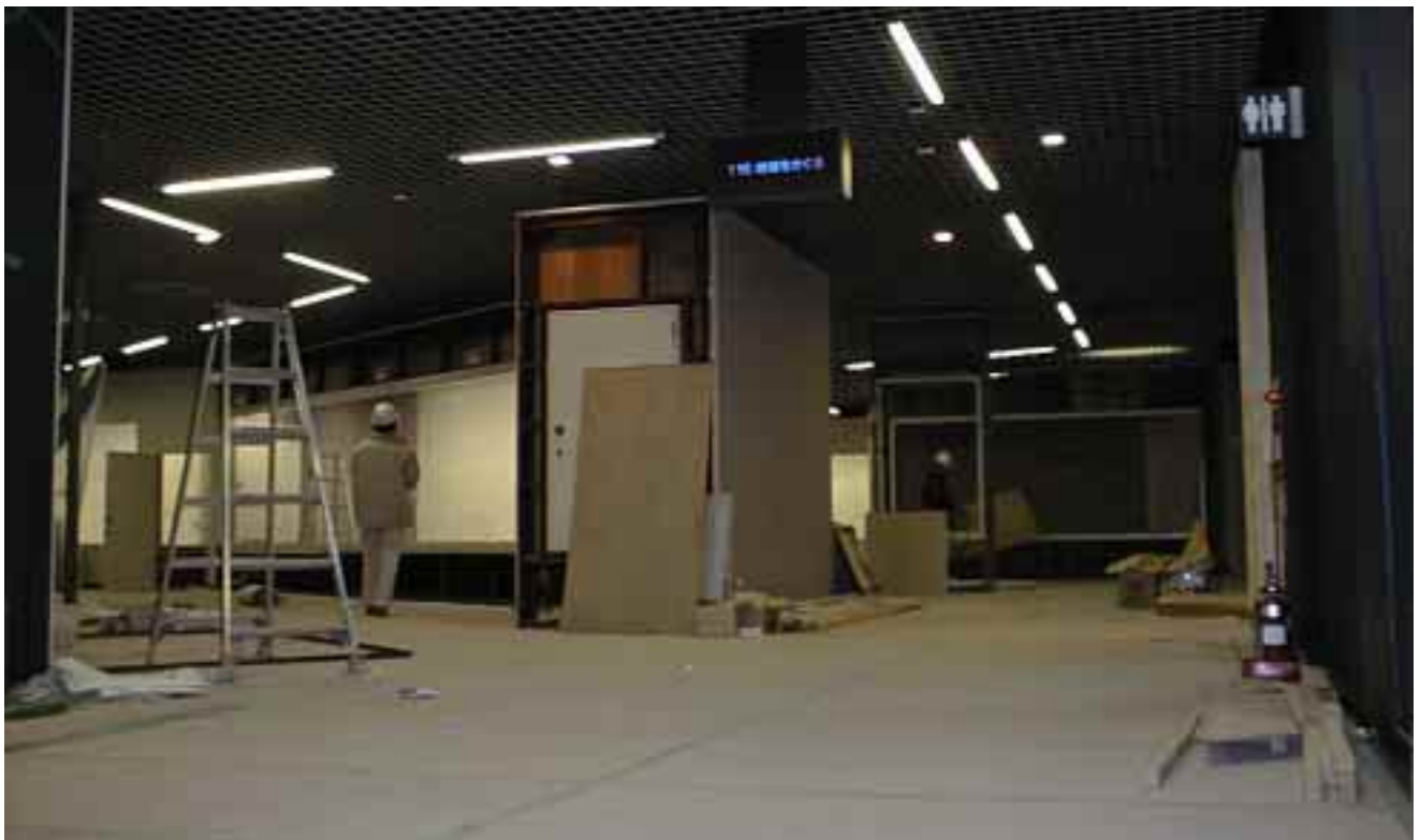
工事中の二階展示室
