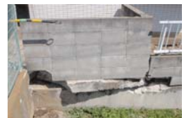
液状化によるブロック塀の破壊(平塚市出縄)
