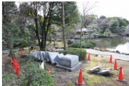
平成23年(2011)3月 東日本大震災の被害 総合公園の転倒した多層塔。
