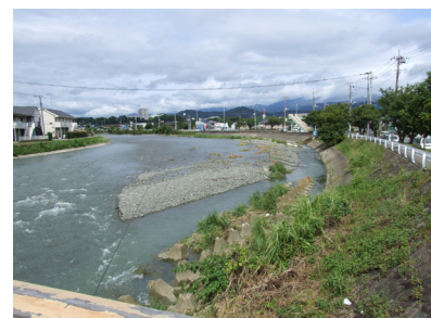
大堤: 徳川家康が普請したと伝えられる金目川の堤防(南金目)
